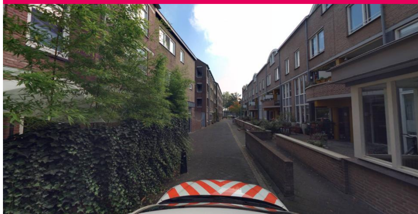
Figuur 6.13: Fysieke barrières en te smal profiel o.a. door de stenen muurtjes
