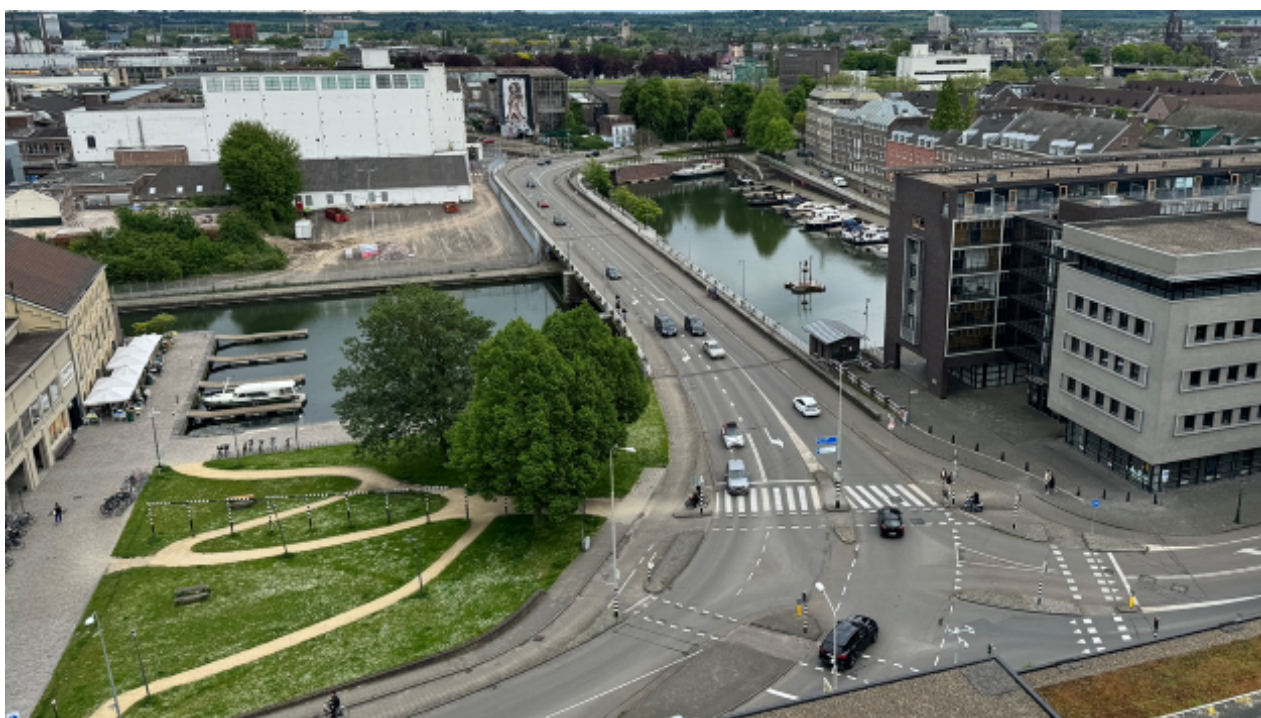
Bassinbrug huidige situatie
